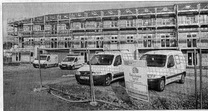
■ Quinze logements en construction aux Rives de l'Autruche.
